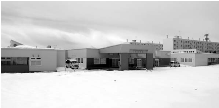
外観(写真中央が正面玄関、左側がユニット棟、右側が多床棟、手前スペースが駐車場、芝生広場造成箇所)
