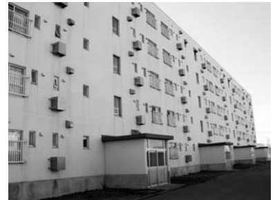
旧雇用促進住宅は購入後、町単独住宅として活用。名称も「栄町夕陽ヶ丘団地」に決定しました。
