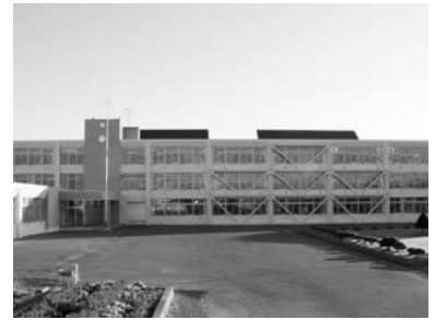
校舎にV字型の耐震用ブレースを取り付け、耐震化を図るとともに外壁改修も実施しました。
