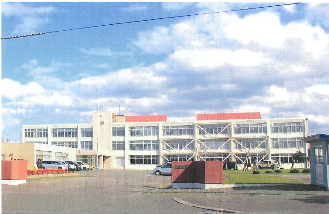
図2-7 耐震補強工事の実施例（羽幌中学校）
