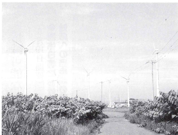
汐見地区の小形風力発電施設
