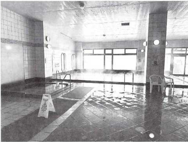
浴場床タイルの修繕を行う（2024年1月撮影）
