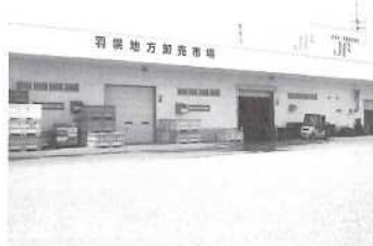
増築される羽幌荷捌所
