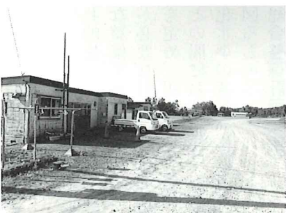
スポーツ公園 (管理棟・園路)
