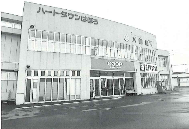
2階が空きスペースとなっている ハートタウンはぼろ
