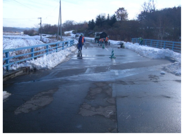
写真3 維持管理状況（霊園橋 橋台背面舗装の修繕）
