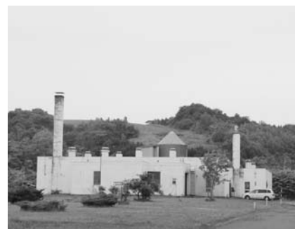
し尿処理施設（北町） 施設の老朽化が心配されているし尿処理場。国道側から、高い煙突のある旧ゴミ処理施設の建物が見えますが、その奥に建っています。
