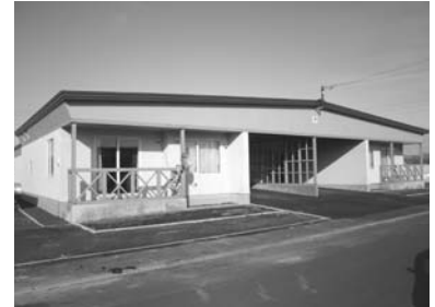
平成13年から計画的に整備が進められている、朝日地区の公営住宅建設事業
