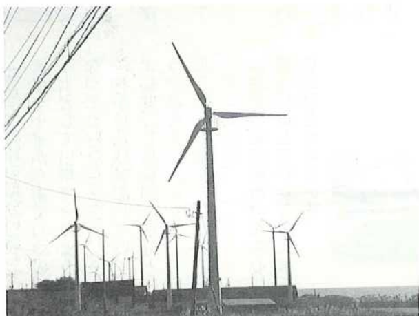
汐見地区の小形風力発電施設
